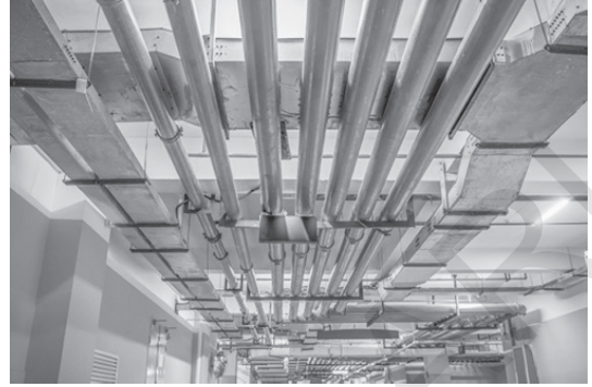
Resim 11.5. Püskürtme Tipi Yangın Söndürme Sistemi
